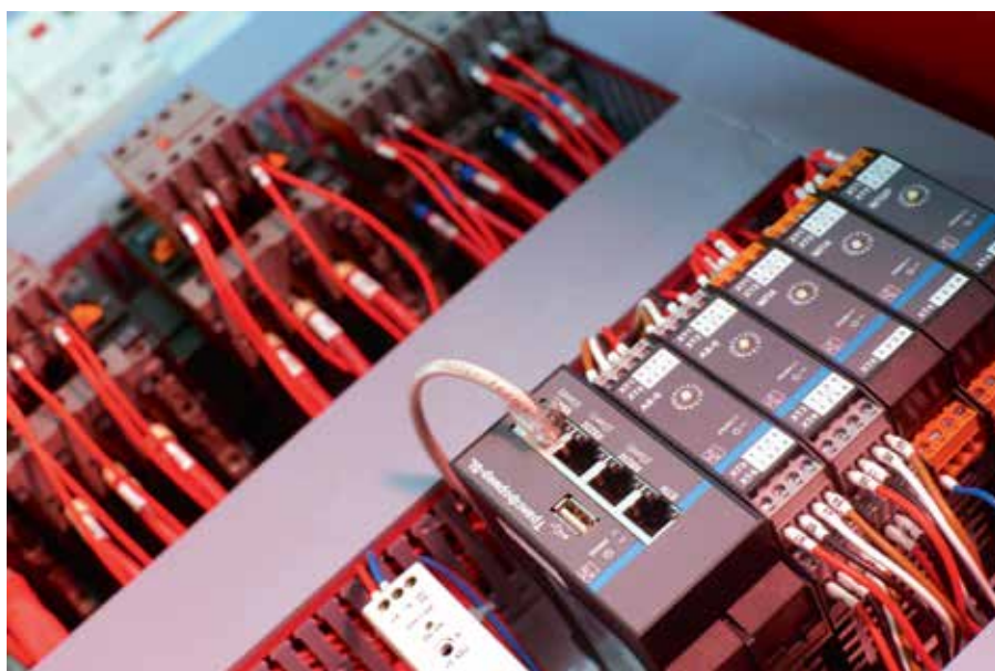
Рис. 2. Шкаф автоматики «ГЕФЕСТ-СПТ»: внутреннее устройство
