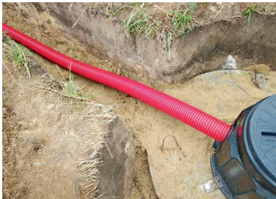
Рис. 4. Монтаж двустенных гофрированных труб «Промрукав» с помощью пластиковых колодцев
