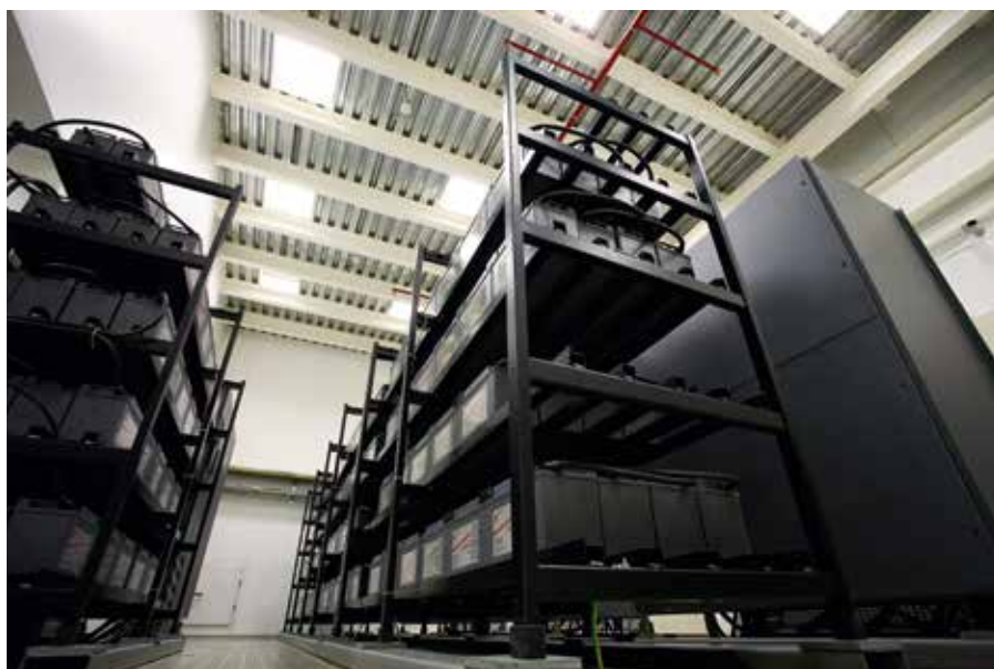
▲ Дата-центр «ТрастИнфо»: рабочие помещения
