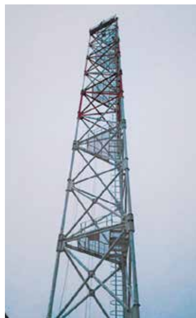
▲ Металлоконструкции, защищенные составом Zincker: слева – автомобильный мост; справа – башня для крепления дымовых труб
