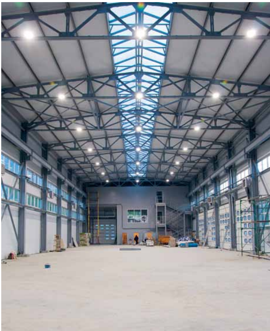
Рис. 2. Освещение нового цеха завода тяжелых машин светильниками FHB
